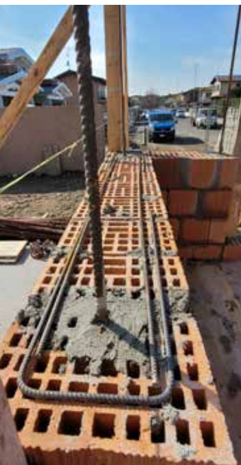
Disposizione delle armature orizzontali con relative sovrapposizioni.
