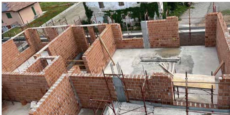
Strutture in elevazione.
