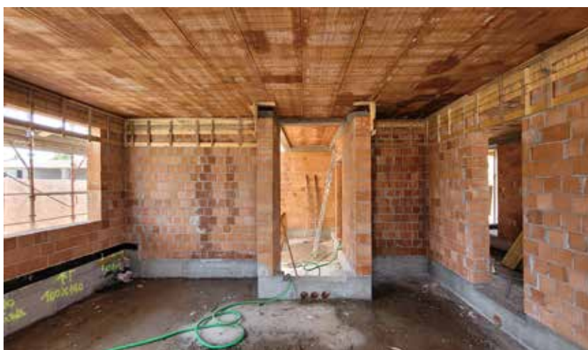
Il cantiere dall'interno.
